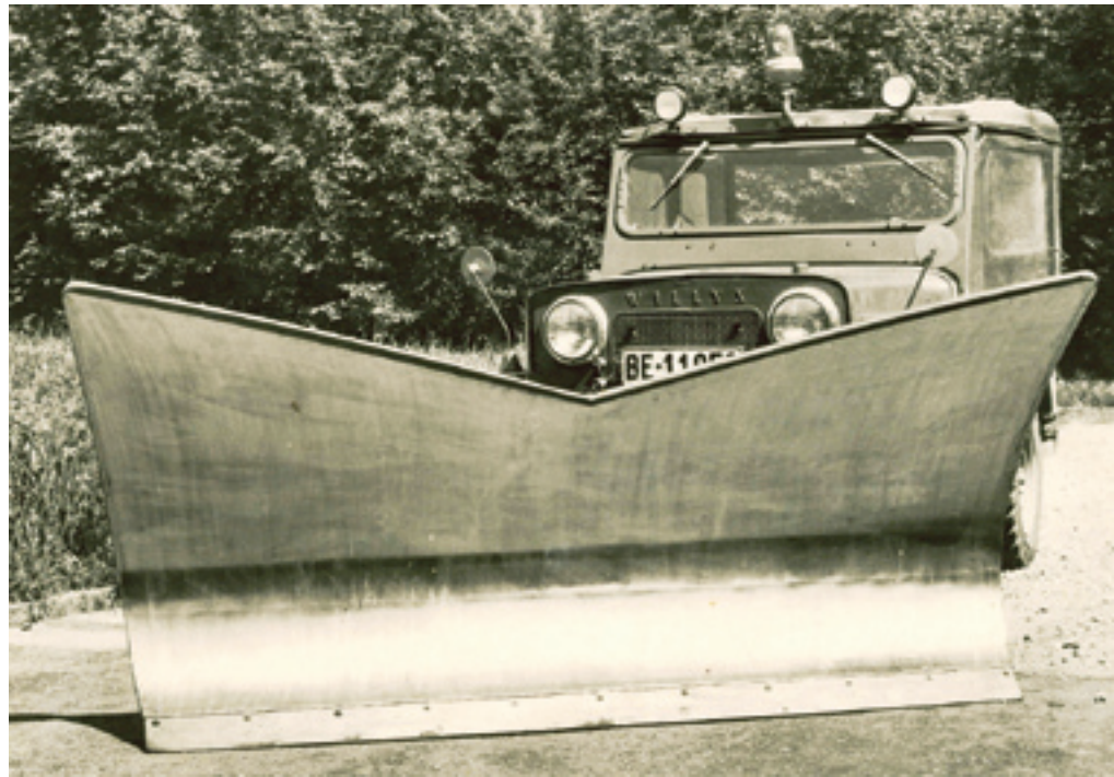
ZAUGG-Schneepflug Mitte der 60er-Jahre. Stahlbauart. Beachtenswert die Form des Räumschildes mit der Mittenkante. Dies stellt sozusagen die dritte Generation von Schneepflügen dar, denn die ersten Pflüge (teils noch mit Pferdebespannung) schoben mittels eines eisenbeschlagenen Holzbrettes den Schnee einfach auf eine Seite. Danach folgten die «Spurpflüge» bzw. Keilpflüge, die den Schnee beidseitig wegschoben. Dieses System wird heute nur noch bei Eisenbahnen angewendet.
